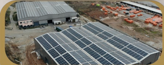
Balıkesir Çatı GES
